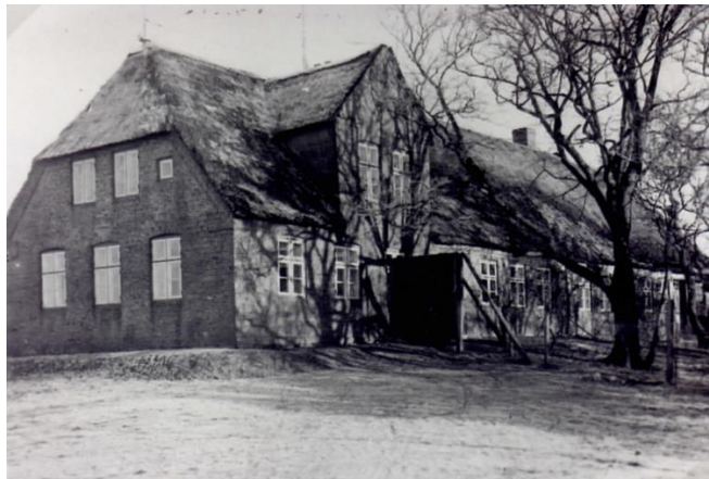
Abb. 3 Die neu zusammengelegte Norder- und Waldhusenschule (ab 1838)
