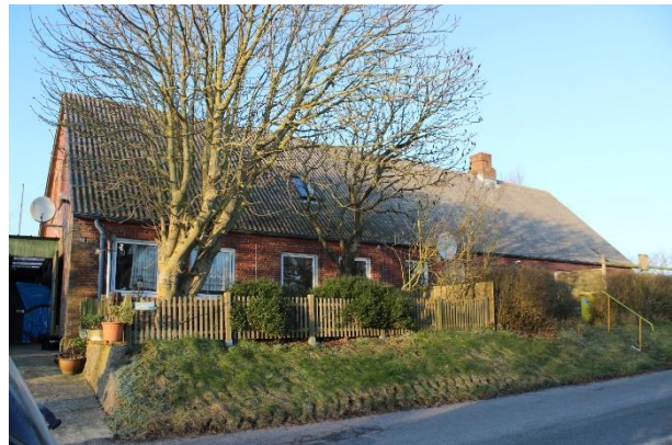
Abb. 2 Das heutige Gebäude der ehemaligen Schüttingschule, Februar 2018
