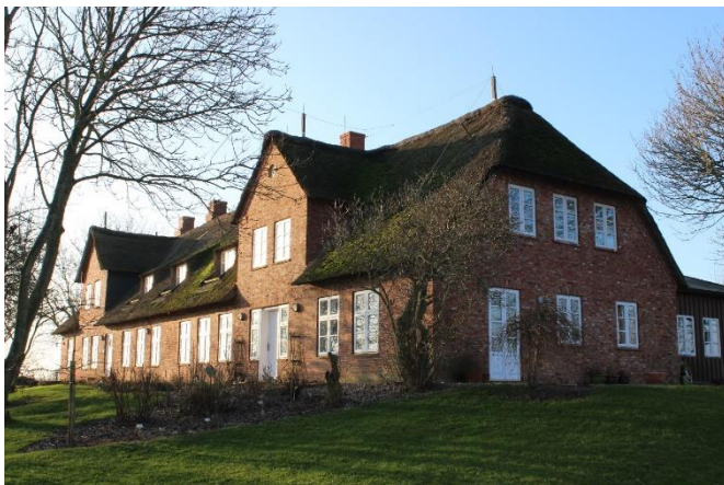
Abb. 4 Das heutige Gebäude der ehemaligen Waldhusenschule, Februar 2018
